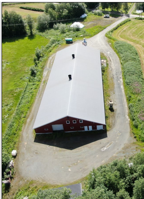
Dronefoto av område sett mot sør. Avkjørselen fra Grubbveien opp til høyre/i sør.
