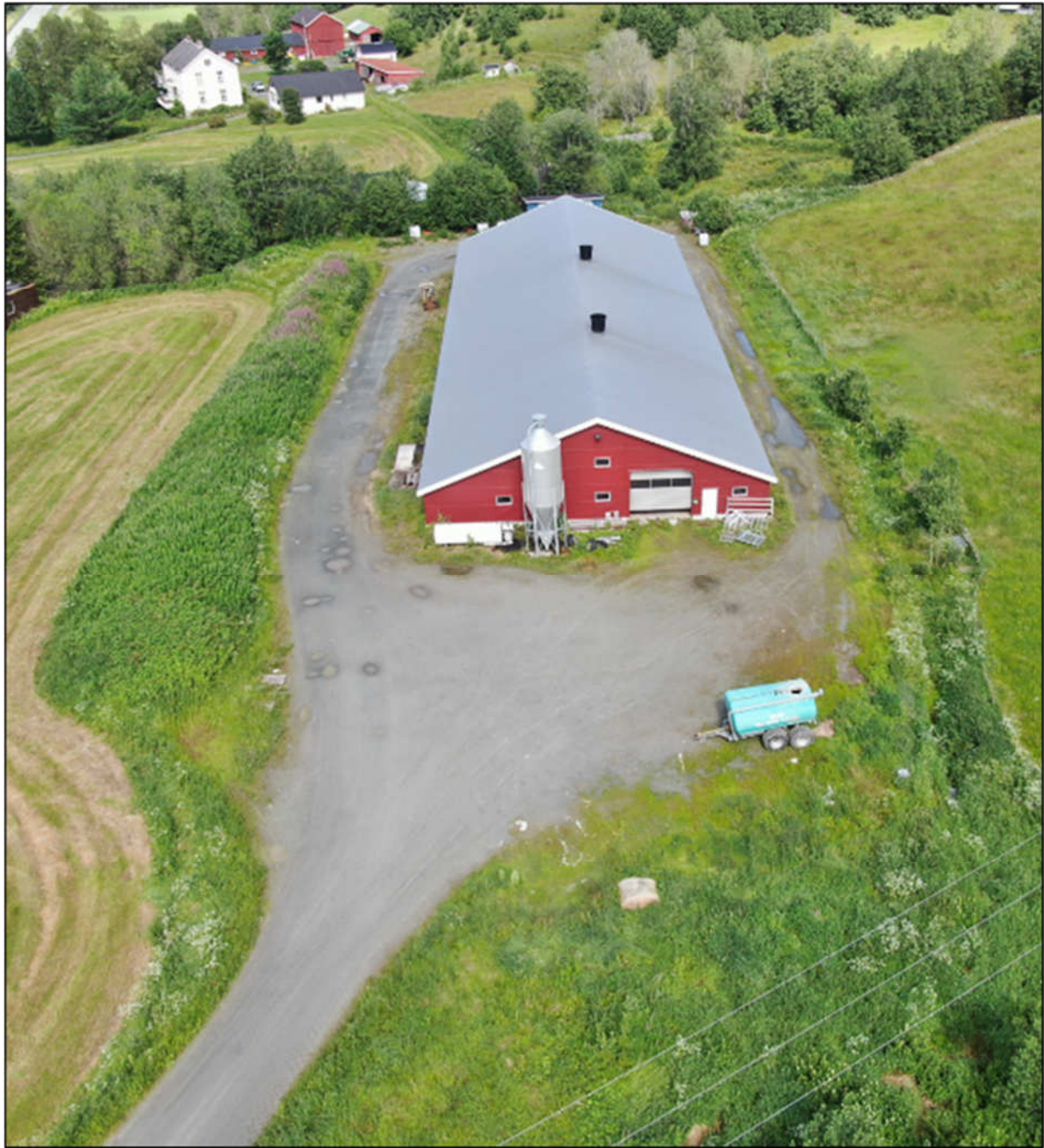
Figur 3. Foto tatt mot nord. Bekkedalen med Kvernbekken og den skogklede kantsonen sees rett på nordsiden, snaut 30 m fra Samdriftsfjøset. Deler av dyrkamarka (0,6 dekar) på 20/4, ned til venstre i bilde, foreslås tilføyd 20/212 for sikre nok plass til renseanlegget, samt for å gi god avkjørsel/adkomst inn på tomte.
