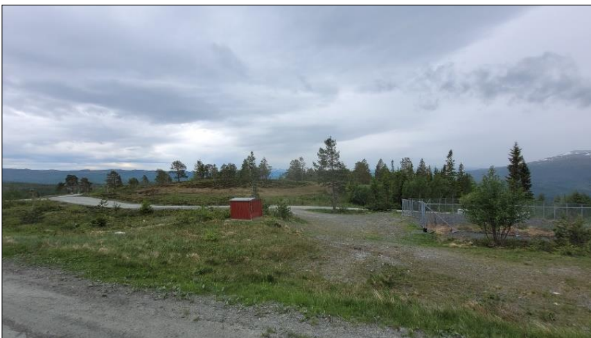
Figur 3-5 Det er trafo og kommunalt vann- og avløpsanlegg i nordvestre del av området.
