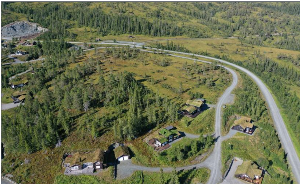
Figur 5-2: Dronebilde som viser planområdet med nærliggende areal
